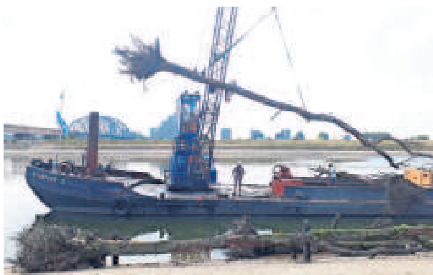
▲ De aanleg van het onderwaterbos in de Spiegelwaal bij Nijmegen. Daar steken de bomen niet boven het water uit. FOTOS: MIRTE VAN LAARHOVEN
